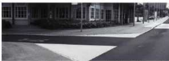
Dans ce contexte contraint, l'équipement de la vitesse a été traité en amont du carrefour. La réduction de largeur de chaussée a permis de gérer le sens et l'insécurité et l'attente du bus tout en proposant un itinéraire plus favorable pour les scolaires.
