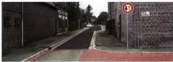
Dans le cas de ce carrefour plus étroit, la création d'un trottoir et le traitement en place ont permis de réinstaurer une continuité du cheminement piéton en accord avec la loi sur la visibilité. La présence d'une école demande de maintenir très large sur l'approche de l'arrêt.
