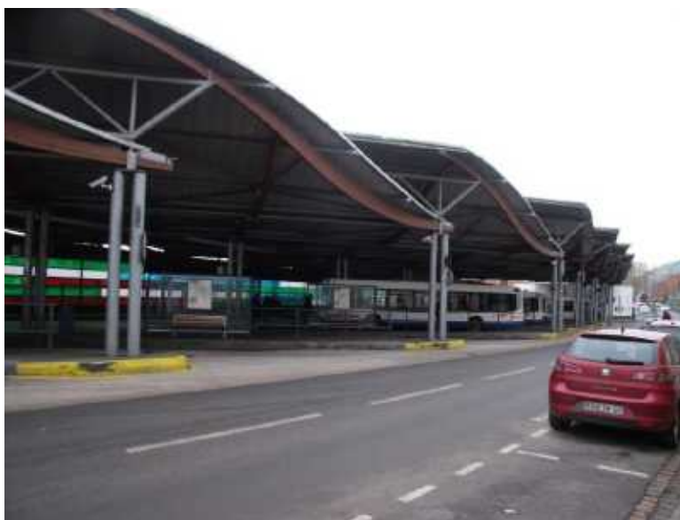
La Gare de Bus Urbains : principal lieu d'échanges et de correspondances du réseau ARTIS
