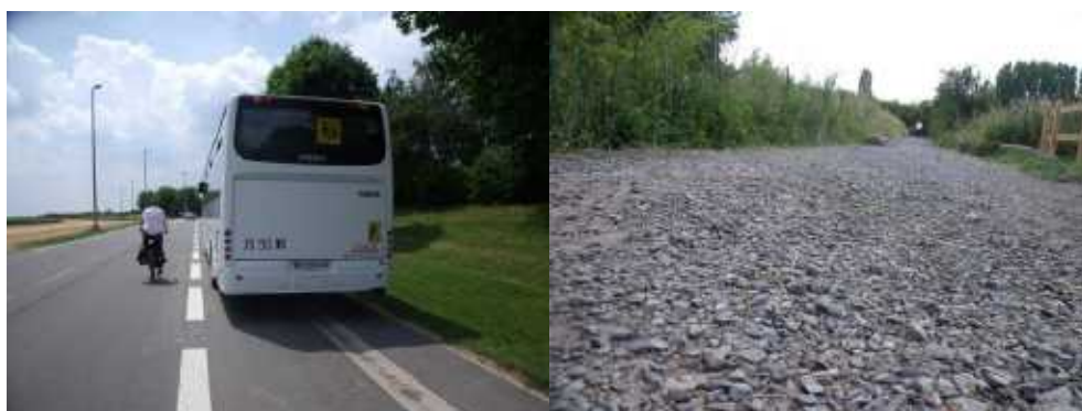
Exemples de dysfonctionnement deux roues : des stationnements illicites qui pénalisent la sécurité des deux roues et la continuité de l'aménagement/problème de revêtement de l'itinéraire cyclable qui pénalise le confort des deux roues
