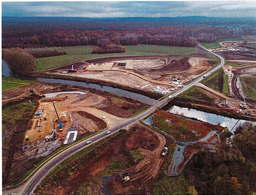
Zones des ouvrages d'art sur le rescindement de l'Oise – décembre 2022
