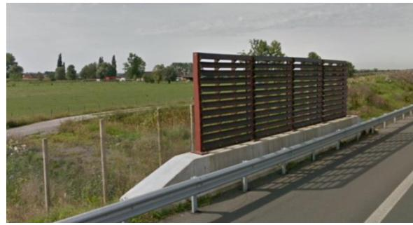
En reprenant les principes d'aménagements des sections de la mesure R8, nous avons identifiés les secteurs où une pose d'un aménagement constitué d'un grillage à mailles fines montant assez haut de type muret serait nécessaire. Nous l'avons identifié par une barre grise en page suivante.
