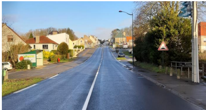
Vue de la RD 901 en amont du passage à niveau caractérisée par une chaussée large 7,50 m accompagnée de 2 trottoirs et zones de stationnement pour les riverains
