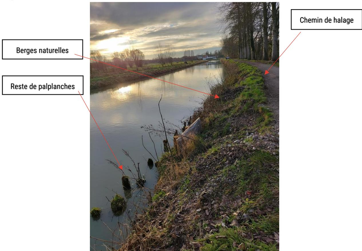
Le canal de Neufossé consiste en un aménagement anthropique, à l'origine pour la circulation fluviale. Les berges étaient initialement aménagées par des palplanches. Les photographies « avant aménagement » témoignent de la présence de ces palplanches. Elles se sont dégradées avec le temps.
