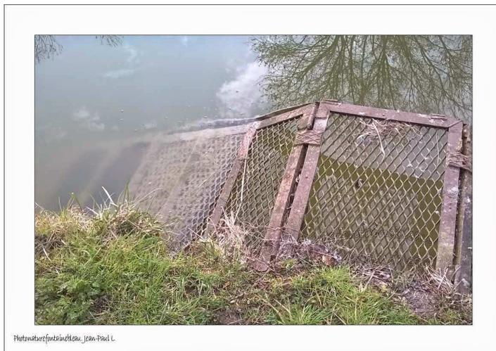
*Exemple de rampe échappatoire au sein d'un canal.*
