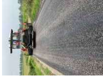
Reconstruction de la chaussée avec une structure drainante sur la RD 228 à Rodelinghem Photo : Maxime Dherbomez
