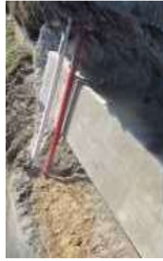
Reconstruction d'une traversée hydraulique sur Muncq-Nieurlet (RD 217)
