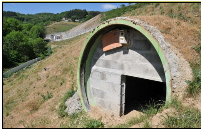
Figure 48 : Vue avant d'un conduit adapté aux mammifères et gîte à chiroptère
