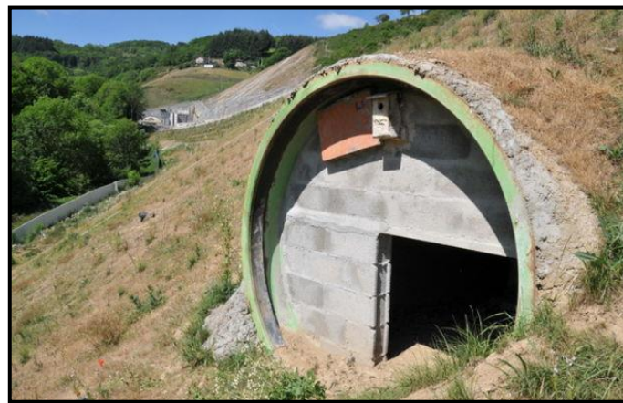
Figure 143 : Vue avant d'un conduit adapté aux mammifères et gîte à chiroptère
