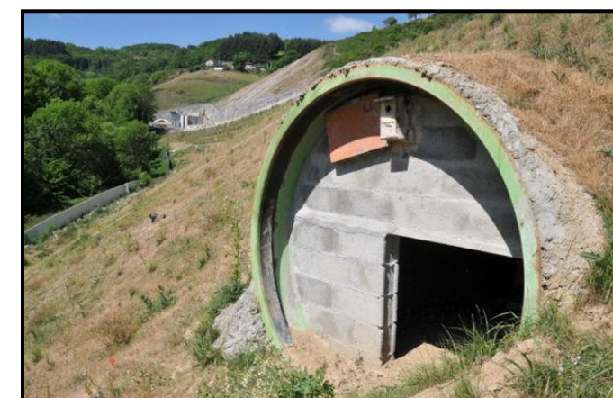
Figure 11 : Vue avant d'un conduit adapté aux mammifères (Source : CMNF)
