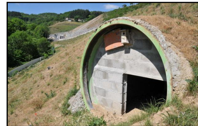
Figure 58 : Vue avant d'un conduit adapté aux mammifères (Source : CMNF)
