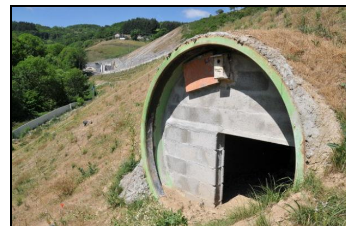
Figure 44 : Vue avant d'un conduit adapté aux mammifères (Source : CMNF)
