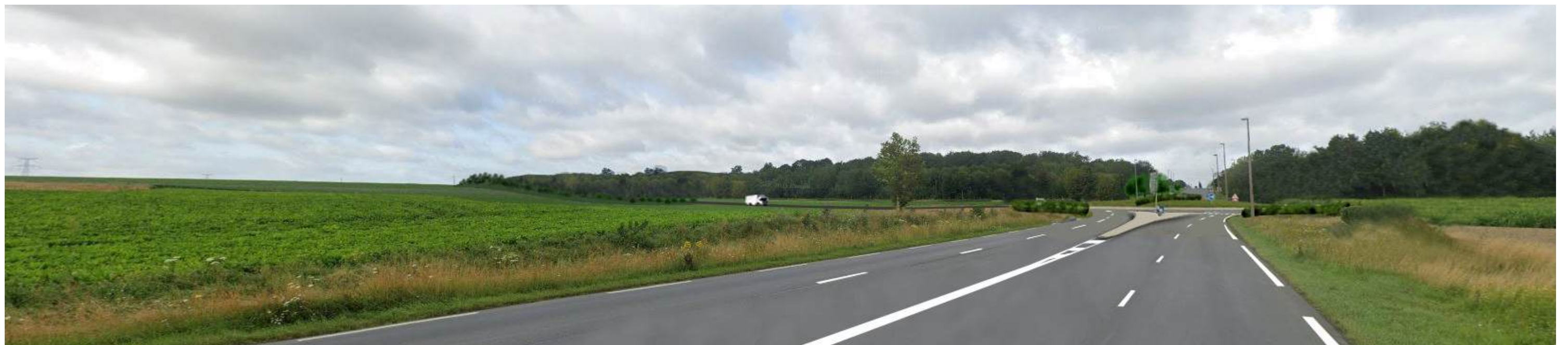
Montage après réalisation de l'ouvrage
