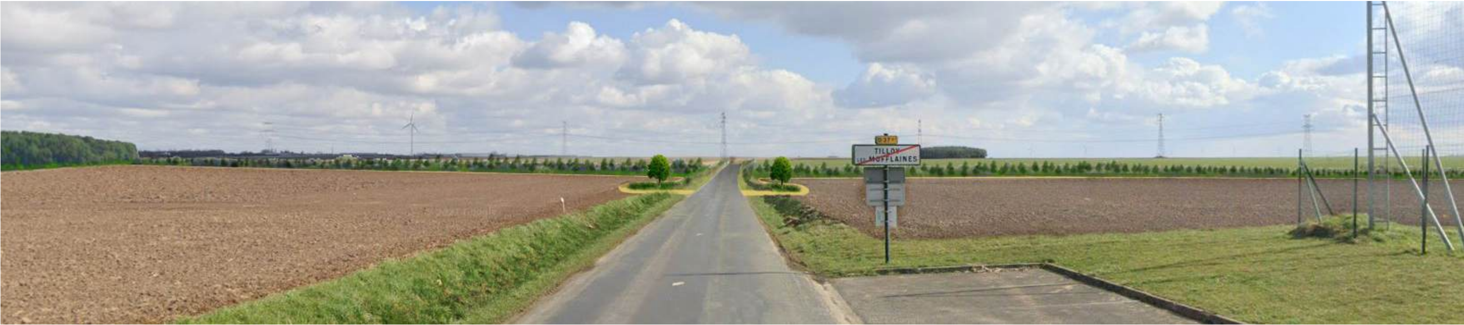
Montage après réalisation de l'ouvrage
