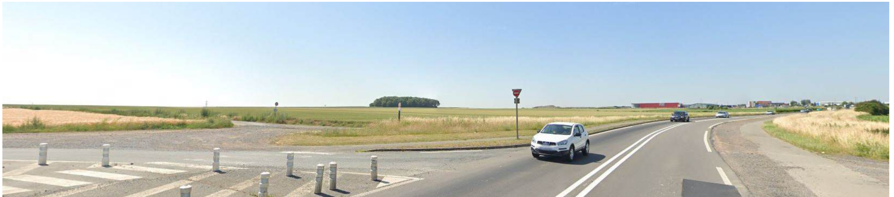
Vue actuelle avant ouvrage - RD 60/croisement av. Charles de Gaulle, à 600 m de la déviation
