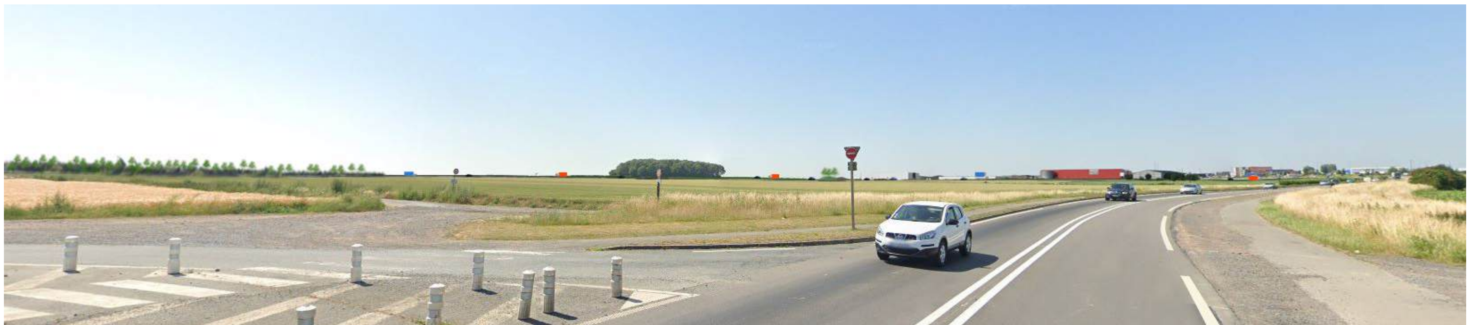
Montage après réalisation de l'ouvrage
