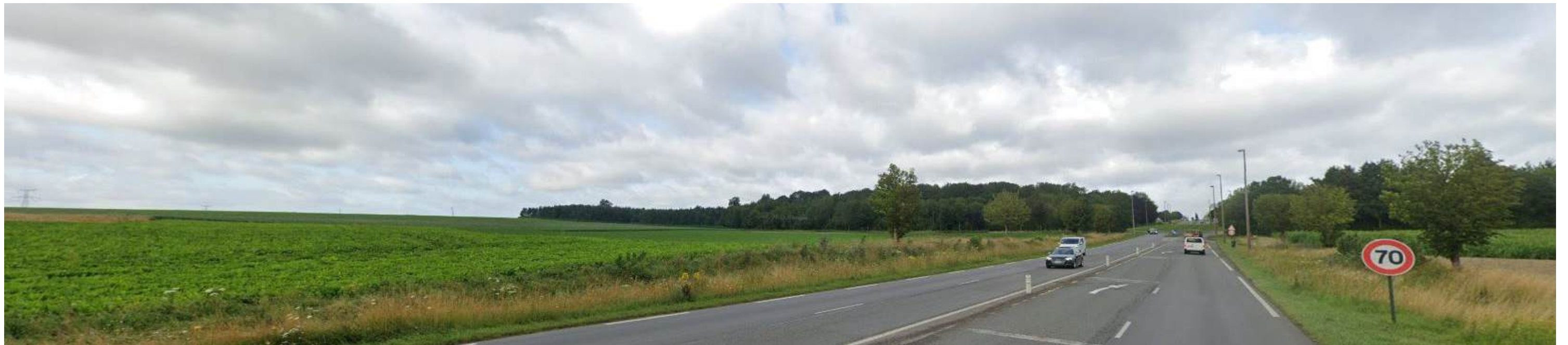
Vue actuelle avant ouvrage - RD 939, à 260 m de la déviation
