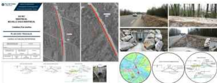
RD 901—réalisation de merlons
