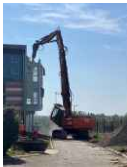
Démolition du collège Jean Rostand à Marquise
