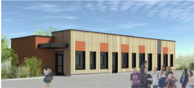
Beuvry, construction de salles d'activités école Albert Camus
