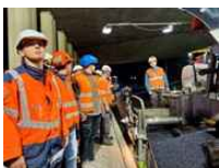
Chantier de nuit RD 57
