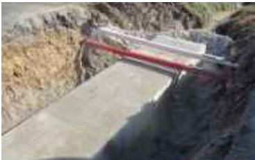
Reconstruction d'une traversée hydraulique sur Muncq-Nieurlet (RD 217) Photo : Maxime Dherbomez
