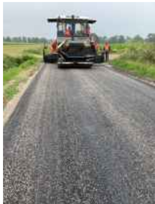
Reconstruction de la chaussée avec une structure drainante sur la RD 228 à Rodelinghem Photo : Maxime Dherbomez
