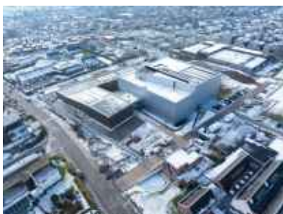
Chantier des archives départementales
