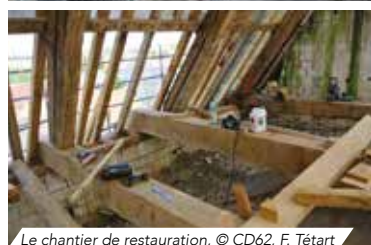
Le chantier de restauration, © CD62, F. Tétart
