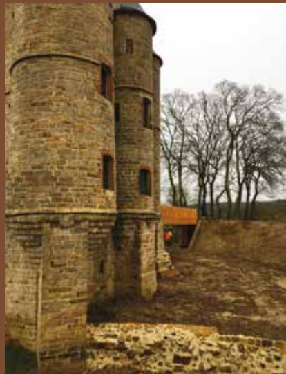
Le dégagement des fondations du donjon, © CD62, F. Tétart
