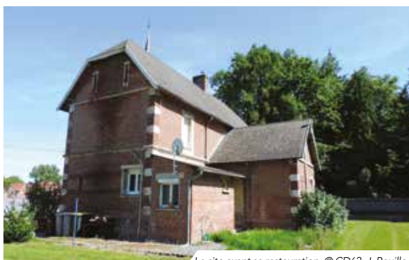
Le site avant sa restauration, © CD62, J. Pouille
