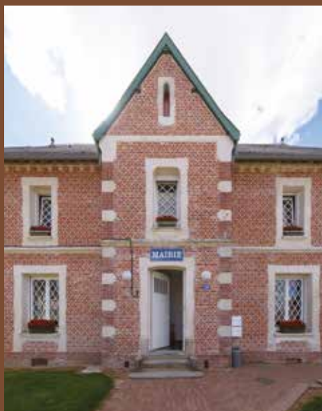
Détail de la façade restaurée, © CD62, J. Pouille
