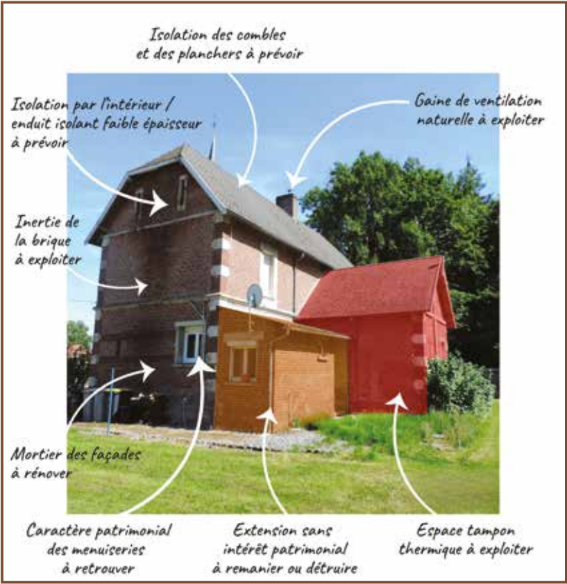
Conseil à Brias, pour la rénovation thermique de la mairie, © CAUE 62
