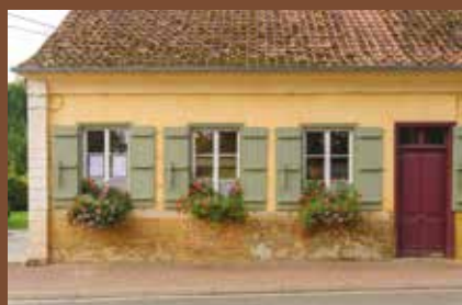
Détail de la façade restaurée, © CD62, J. Pouille
