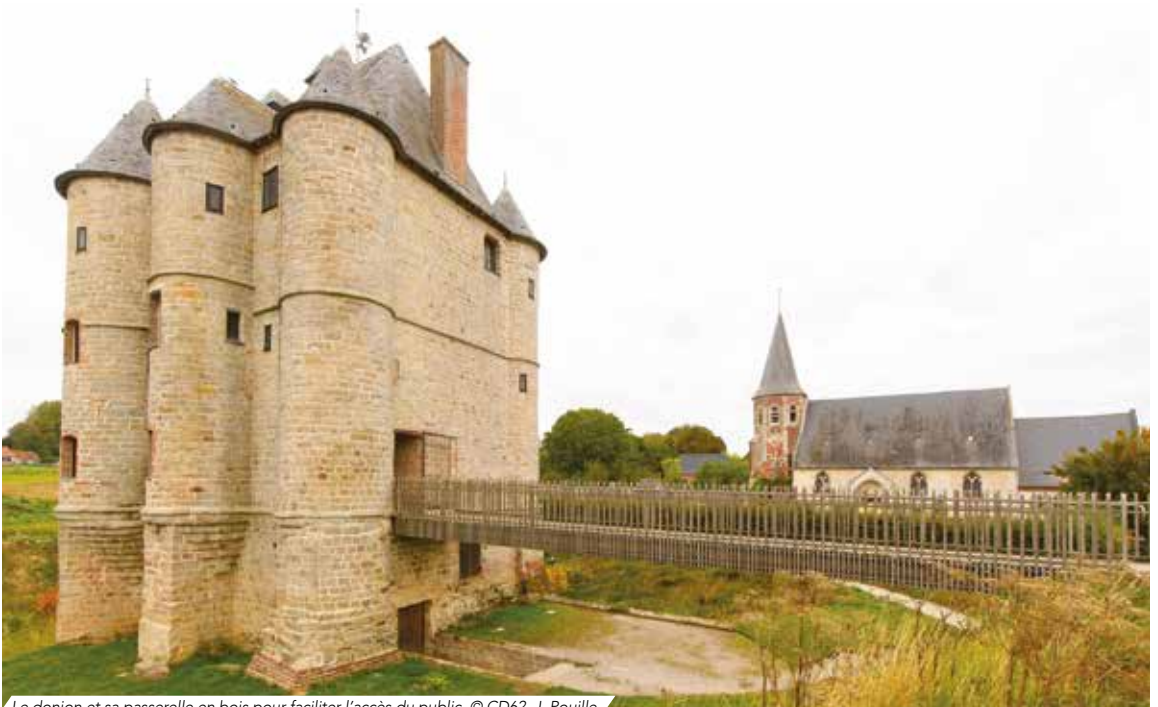
Le donjon et sa passerelle en bois pour faciliter l'accès du public, © CD62, J. Pouille
