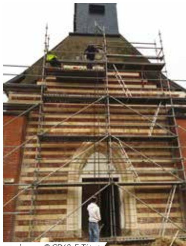
Le remontage progressif de la façade en rouges barres, © CD62, F. Tétart
