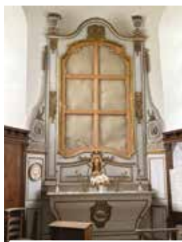
Le châssis de l'œuvre, © CD62, F. Tétart
