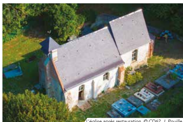
L'église après restauration, © CD62, J. Pouille
