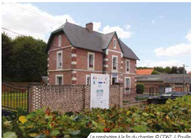
Le presbytère à la fin du chantier, © CD62, J. Pouille
