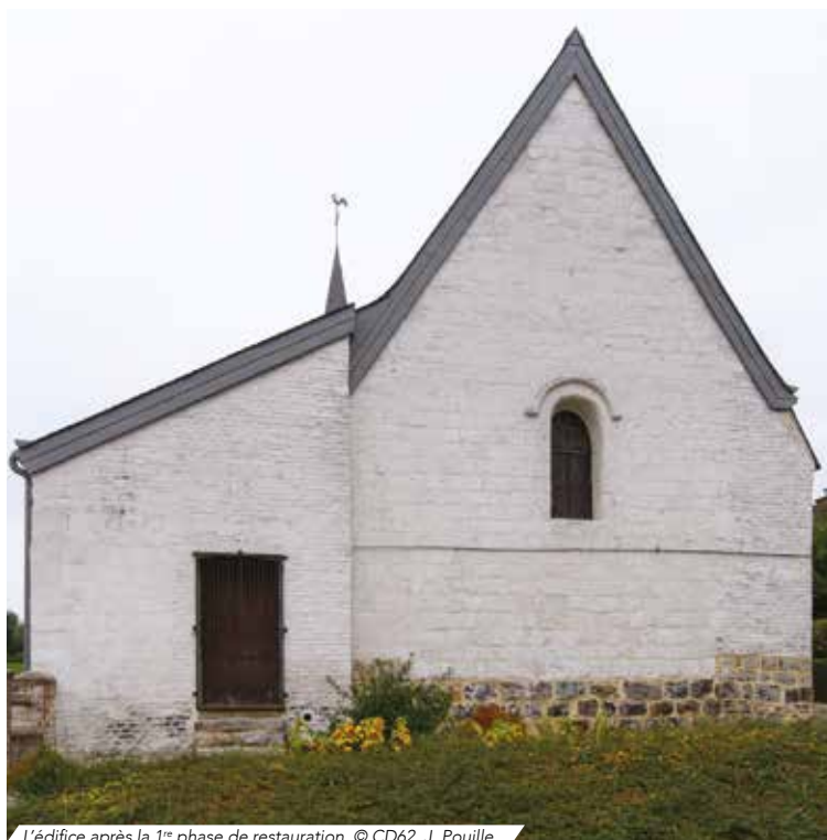
L'édifice après la 1 re phase de restauration, © CD62, J. Pouille
