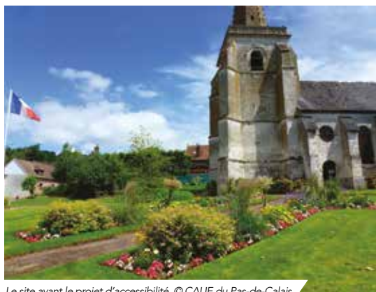
Le site avant le projet d'accessibilité, © CAUE du Pas-de-Calais
