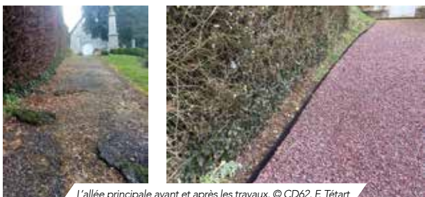
L'allée principale avant et après les travaux, © CD62, F. Tétart
