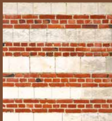
Détail de la maçonnerie en rouges barres, © CD62, J. Pouille
