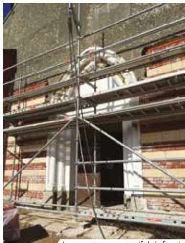
Le remontage progressif de la façade en rouges barres, © CD62, F. Tétart
