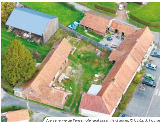
Vue aérienne de l'ensemble rural durant le chantier, © CD62, J. Pouille
