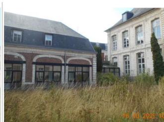
Bâtiments E à droite et F
