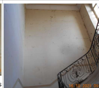
Dans les escaliers également
