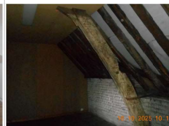
Poutres en mauvais état
