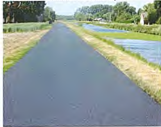
Reprise de l'enrobé de la rue du Canal entre Polincove et Audruicq
