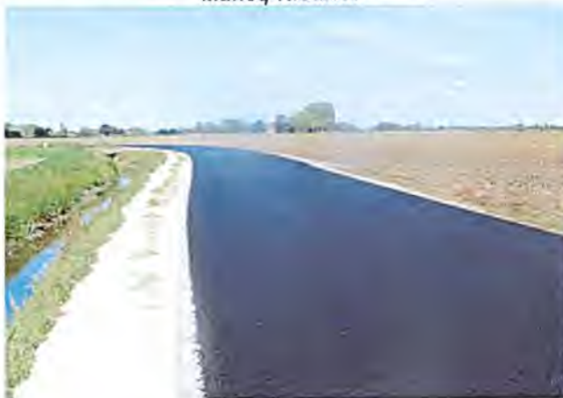
Reprise du chemin des Fermes entre Polincove et Muncq-Nieurlet
