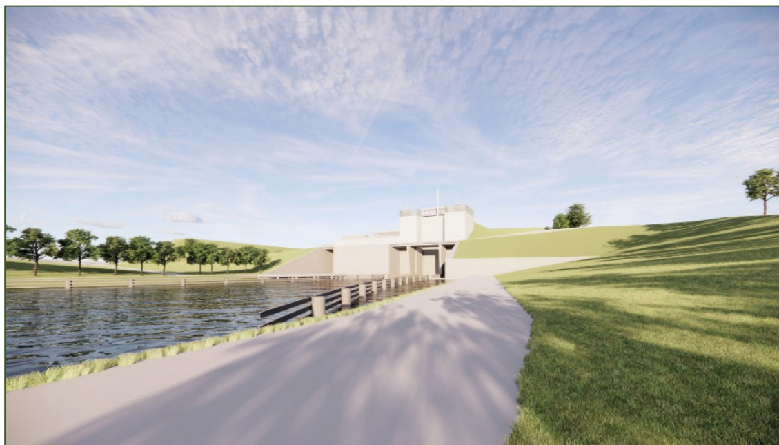
Écluse d'Oisy-le-Verger (Source : ONE, 2021)
