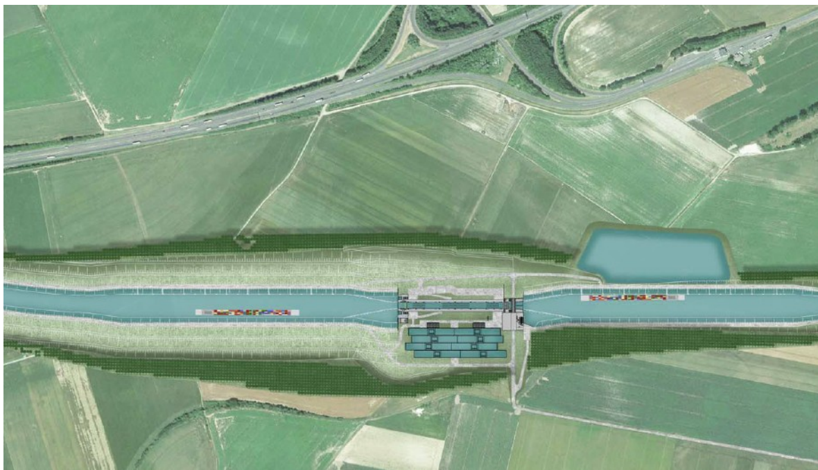
Écluse de Marquion (hauteur de chute de 25,71 m)
