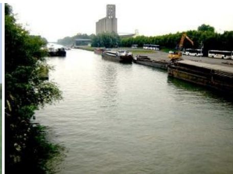
Silos à Marquion
