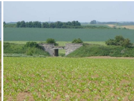
Ancienne voie ferrée
