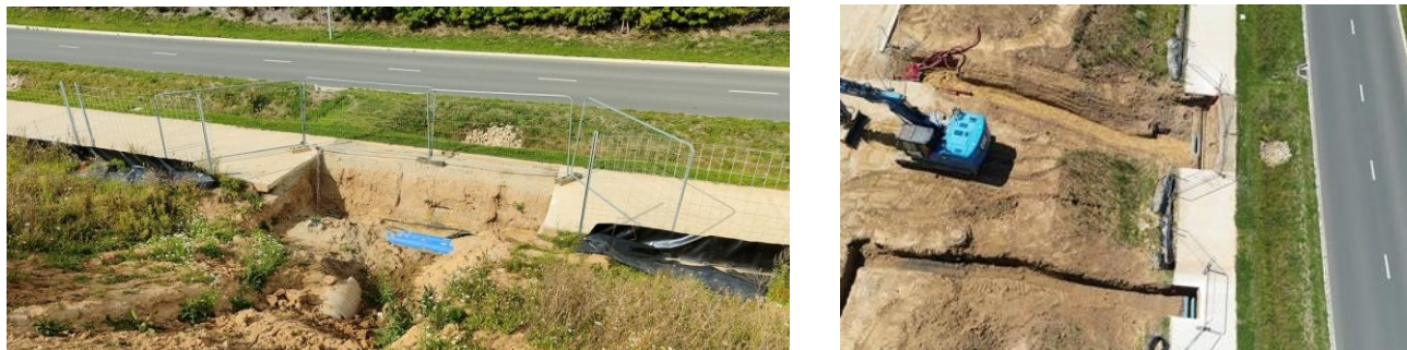
Figure 67 : Ancien drain d'évacuation des eaux de la BA103 coupé sur l'actuel site E-Valley (Source : BT Immo Group)
