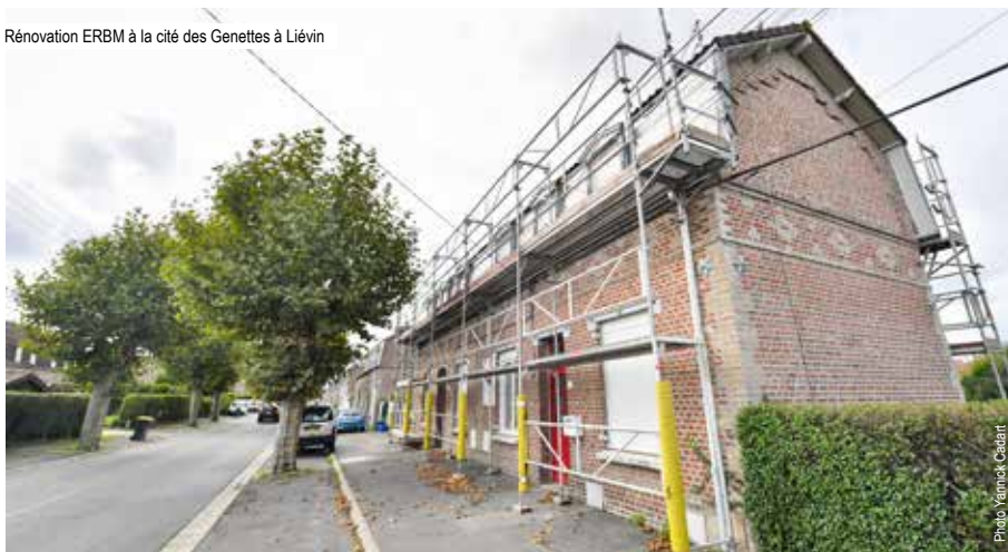
Rénovation d'un logement ERBM à la cité du Parc de Méricourt
