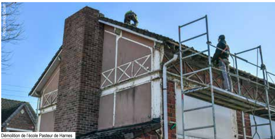
Démolition de l'école Pasteur de Harnes
