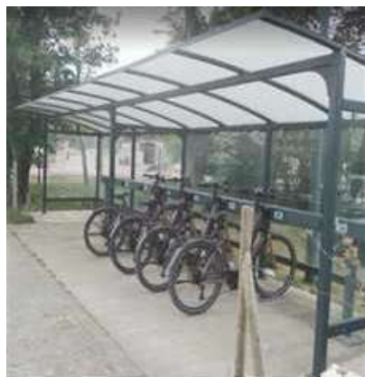
Abri vélo électrique, aire de covoiturage Minoterie, photo Mockelyn Camille, 2023
