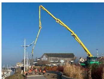
Promenade de plaisance – coulage du béton Photo : G. Routier
