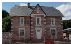
Rénovation – Maire de Brias
