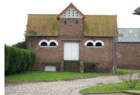
Un pigeonnier dans une cour de ferme à GRAINCOURT-LES-HAVRINCOURT
