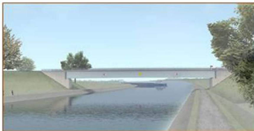
Ouvrage de type Bipoutre (source : ONE 2021)
