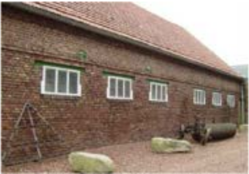
Un bâtiment de la reconstruction (et deux beaux grés mamelonnés)
