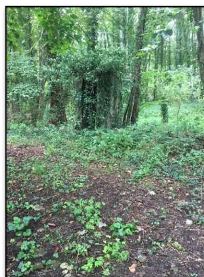
Guérite de surveillance sous la végétation
