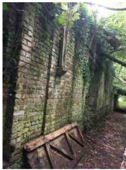
Reste de mur d'un bâtiment brique
