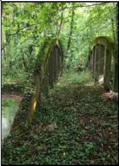
Pont sur l'Aa
