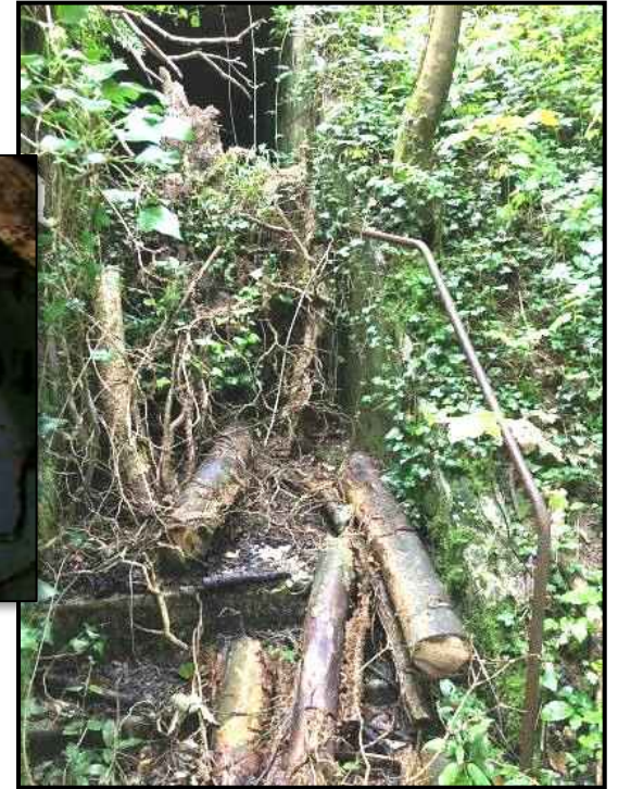
Tunnel enrichié sous merlon
