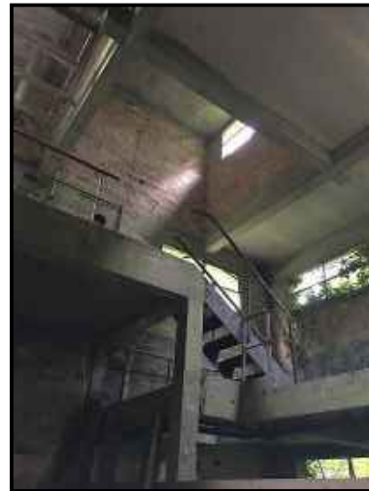
Bâtiment industriel à sécuriser
