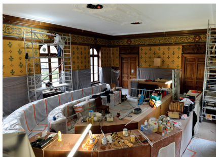
La salle historique lors de sa restauration en 2015
