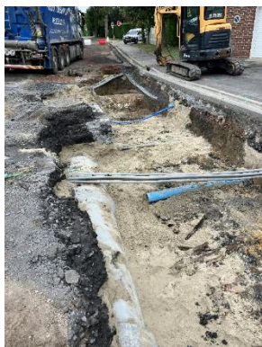
Sailly-sur-la-Lys – RD 945 Démarrage des travaux
