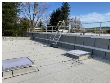
Collège Paul Eluard St Etienne au Mont - Toiture terrasse Photo : A. Saint-Georges
